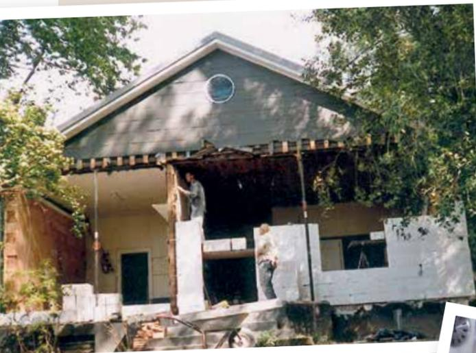
Wegen des Pilzbefalls mussten 2001 bis 2002 alle Außenwände und der komplette Fußboden erneuert werden.
